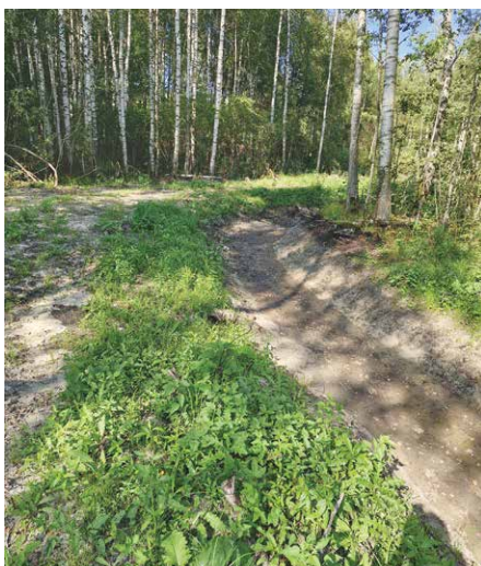
Šā gada pavasarī tika izrakts meliorācijas grāvis un izveidots ceļš vietā, kur iepriekš ūdens sniedzās līdz potītēm
