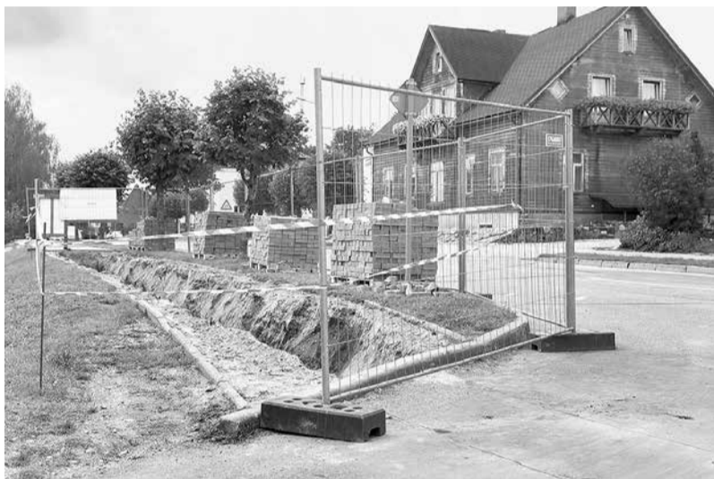
Siltumtrases izbūve Valmieras ielā, Madonā.
