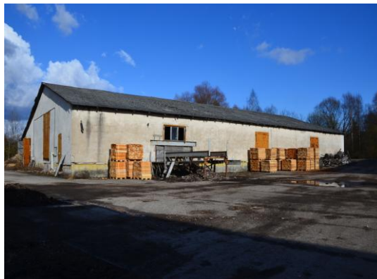
13.att. Skats uz esošo ēku (plānoto katlumāju)
