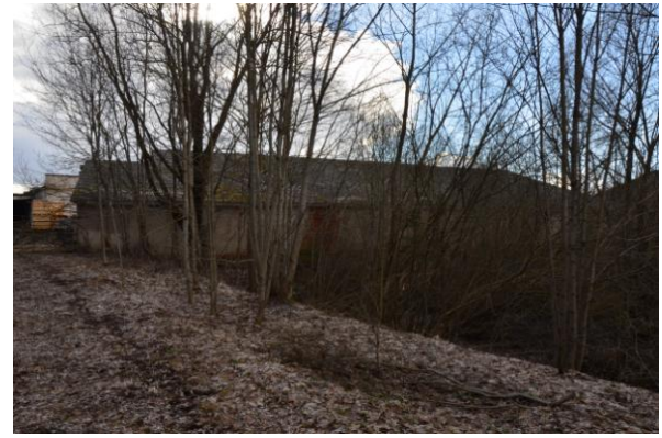
19.att. Lokāplānojuma teritorija no demontētā dzelzceļa uzbēruma puses.
