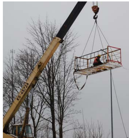
Tiek nomainītas ielas apgaismojuma izdegušās lampas.
